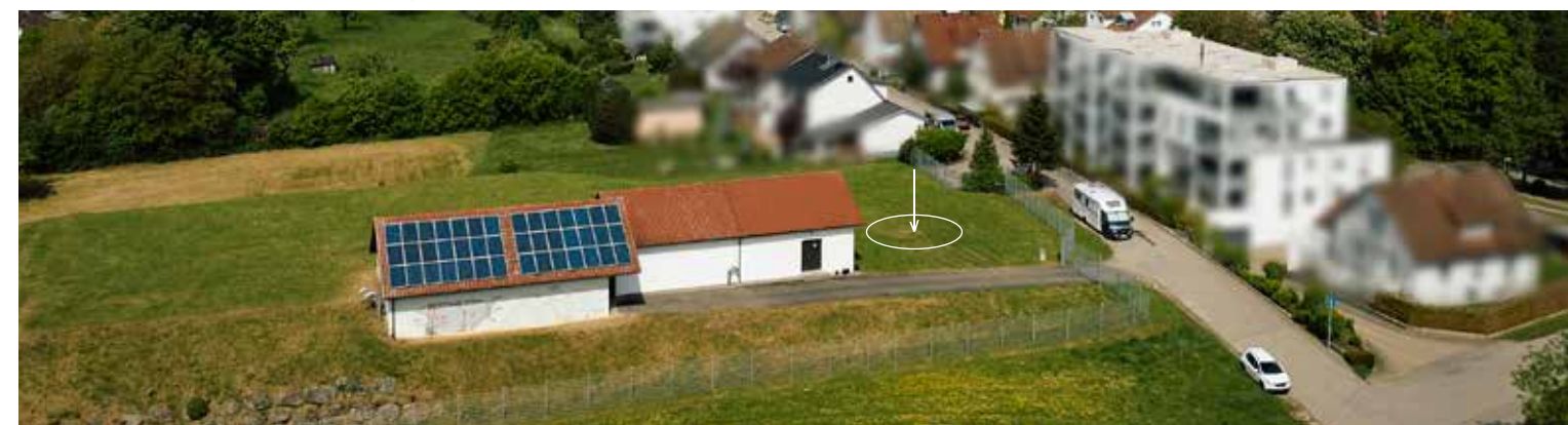
Hier wird derzeit die dritte Wasserkammer gebaut.
