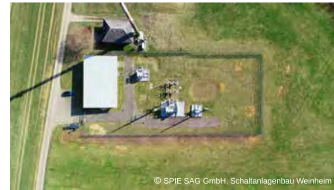
Luftbild der Anlage vor (l.) und nach dem Umbau (r.)
