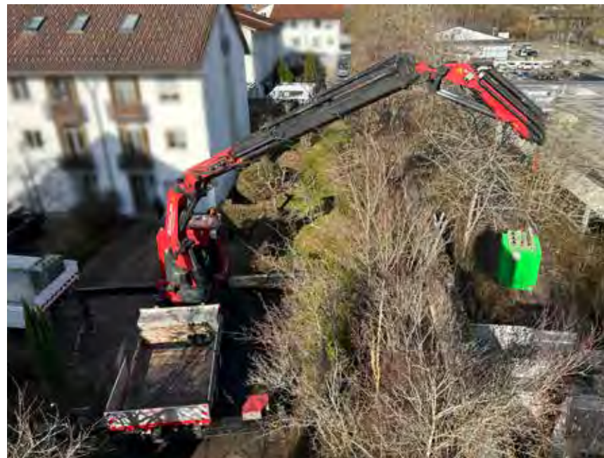
Präzisionsarbeit: Mit einem Spezialkran wurde der neue Trafo von oben in die Station gehoben.
