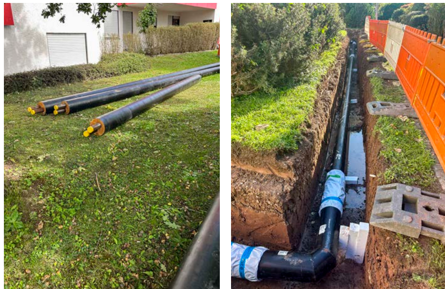
Kunststoffmantelverbundrohre (KMR-Rohr) vereinfachen nicht nur die Tiefbauarbeiten, sondern reduzieren gleichzeitig die Wärmeverluste.
