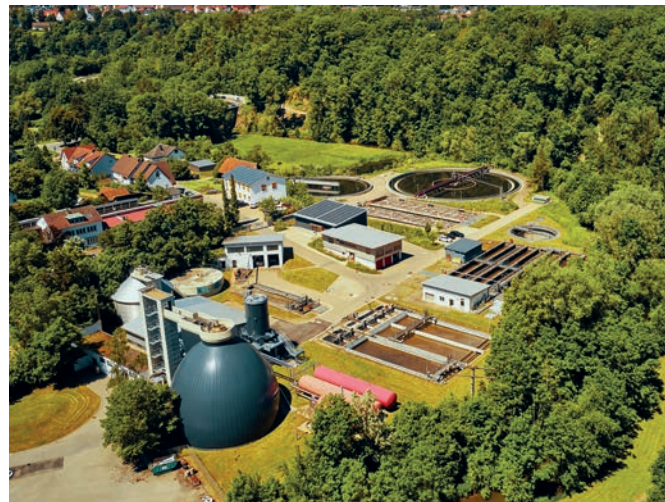
Für den Anschluss der beiden Gemeinden Villingendorf und Dietingen wird die Kläranlage Rottweil in diesem Jahr erweitert.
