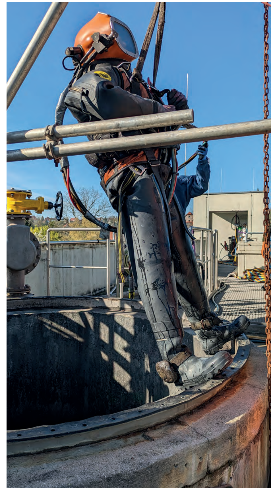
Im Einsatz für Extreme: Der Faulturmtaucher steigt in den Faulturm des Eigenbetriebs Stadtentwässerung hinab.
