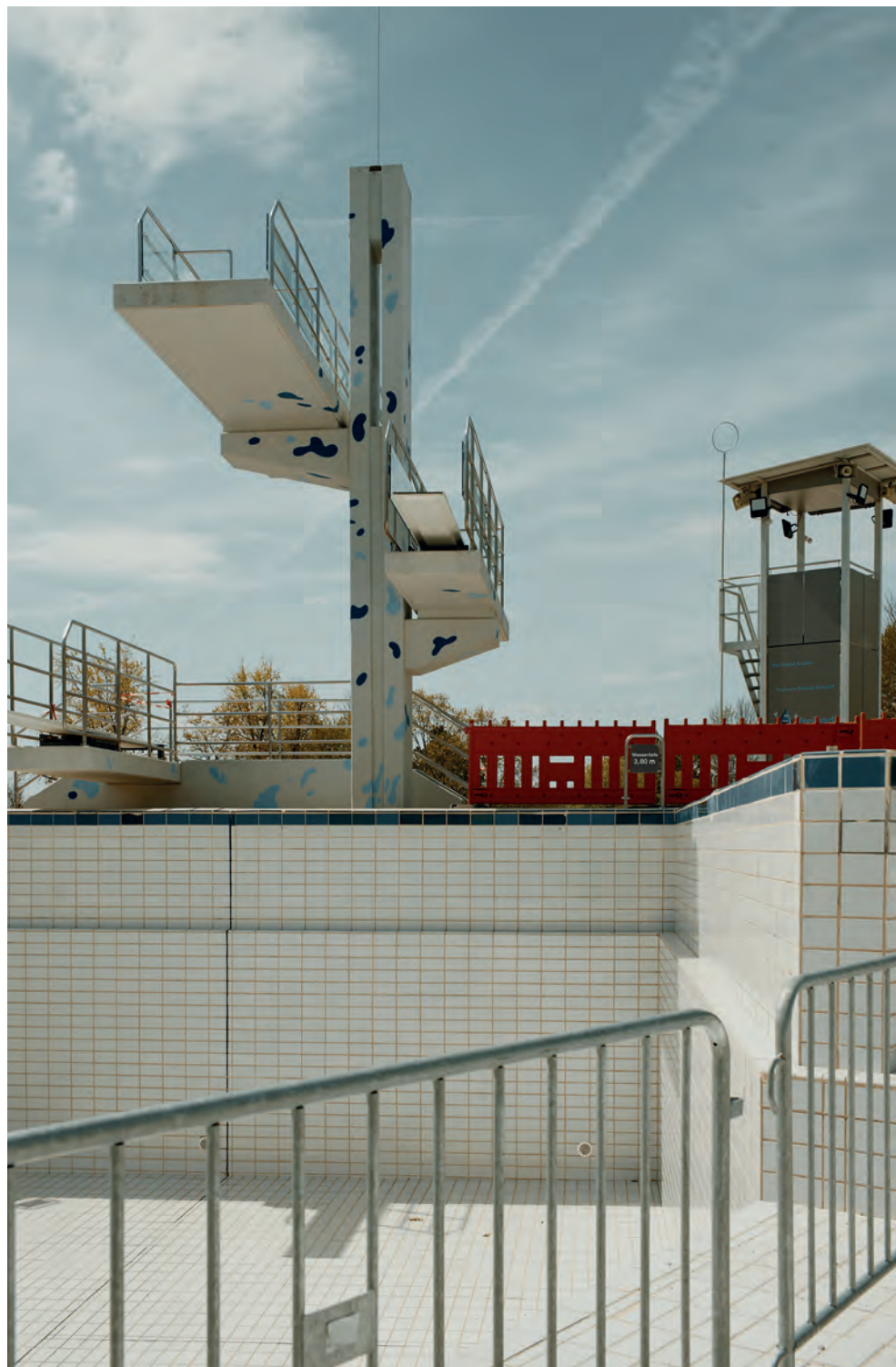
Das Freibad Rottweil während der Auswinterung
