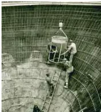
1961: Der Trichter des Nachklärbeckens wird betoniert
